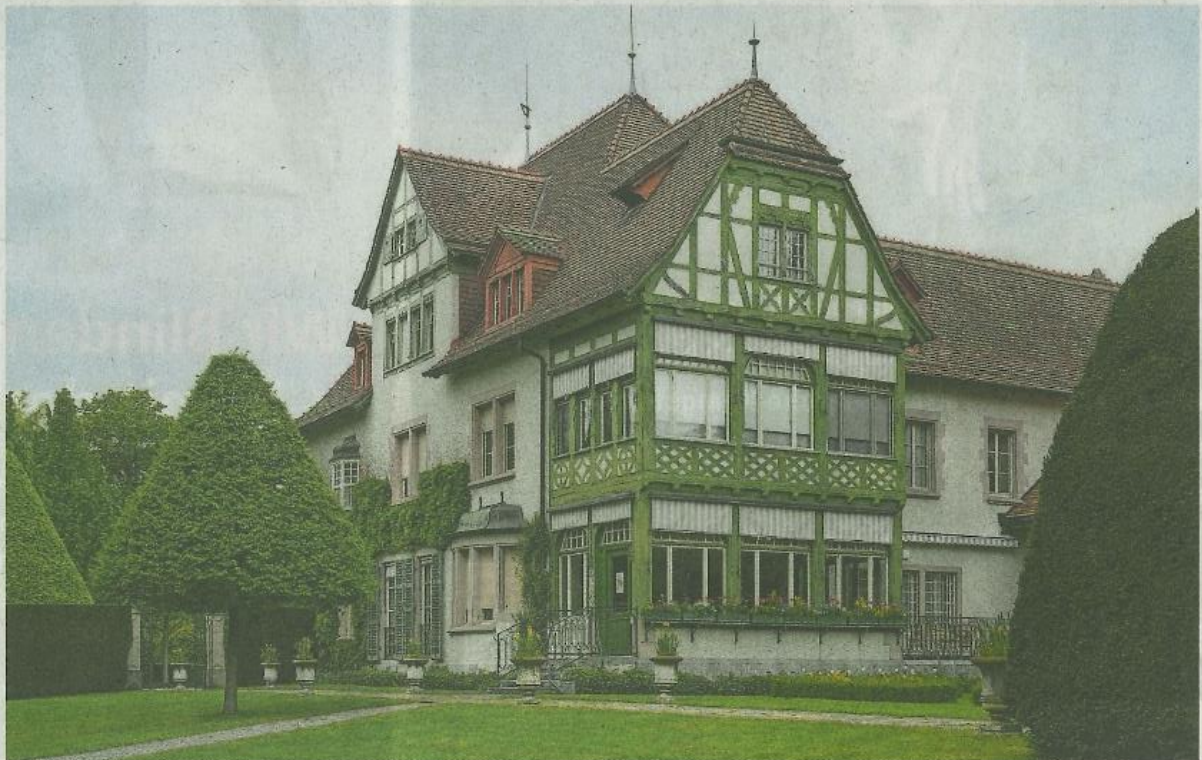
Die Villa Langmatt ist sanierungsbedürftig.
