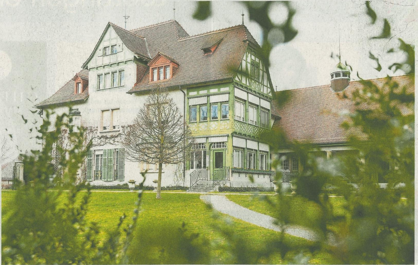
Ein doppelter Sanierungsfall: Sowohl Liegenschaft als auch Stiftung Langmatt sind auf viel Kapital angewiesen.
